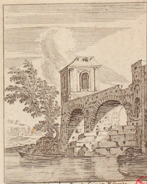
Partie du Pont saint Esprit.
